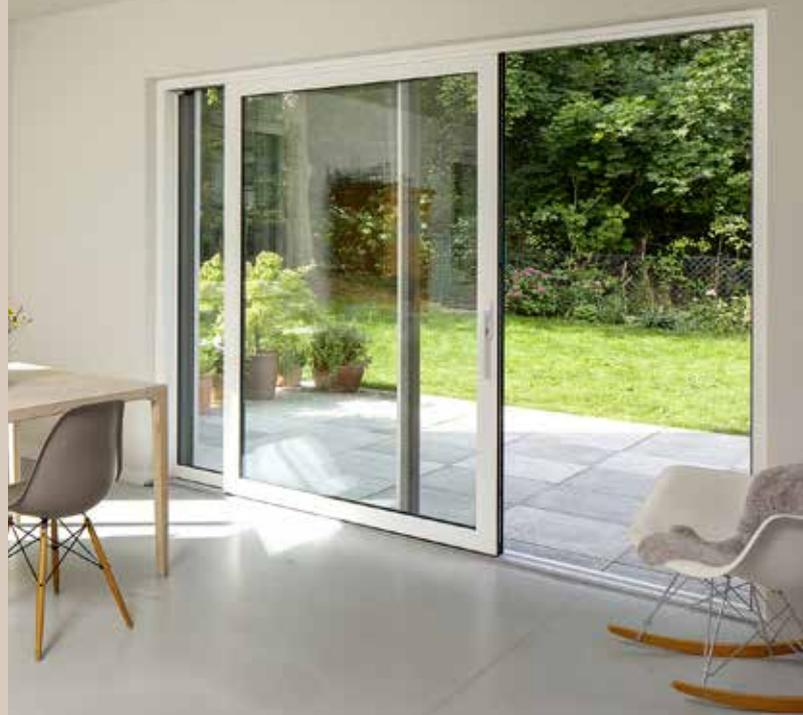
net. Und Nullschwellen haben eben keine Verriegelungspunkte entlang der Schwelle. In der Regel haben sie Magnetdichtungen, die aufgrund des fehlenden Anpressdruckes nie dieselbe Dichtwirkung aufbringen wie eine Anschlagdichtung.
